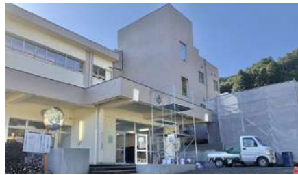
旧東吾野小の 改築工事の様子
